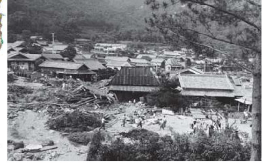
福田地区 伊豆川が氾濫し、民家の軒先まで土砂が押し寄せた。伊豆川と近谷川の合流点より上流のようす。
