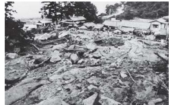
岩谷地区 裏山からの土石流により、民家は跡形もなく押し流された。(椎木川付近)
