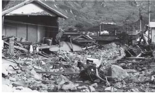
神懸通地区 山崩れ、土石流などが発生し、地区全体では重軽傷者 10 人、全壊 4 戸、半壊 22 戸、床上床下浸水 254 戸を記録した。
