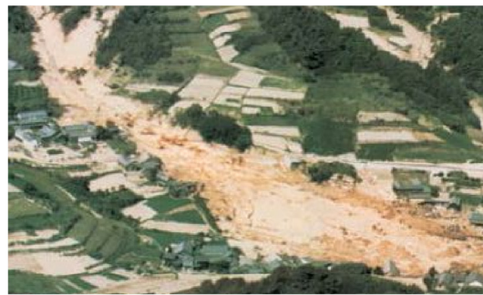
蒲野地区 (谷尻) 死者 24 人、重傷者 4 人、軽傷者 3 人、全壊家屋 20 戸、半壊家屋 2 戸と、谷尻地区の被害は最も大きかった。
