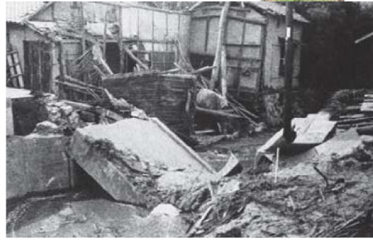
安田地区 安田大川は堤防が決壊し、ずたずたになった。川は大量の土砂で埋まり、倒壊した家の棟木や、根の付いたままの流木などが橋を塞ぎ、濁流が街なかへと氾濫した。また、諸口川 5 号橋は、破壊されて落ちた。
