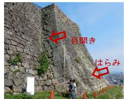
図-1 変状の進む丸亀城石垣
