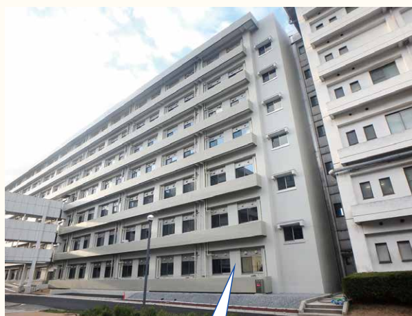
基礎臨床研究棟（外観写真）
