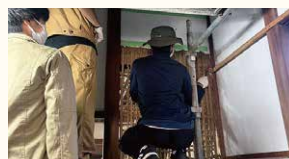
伝統工法を学ぶ施工ワークショップ
