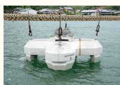
防災機能と藻場造成機能を有する構造物の沈設
