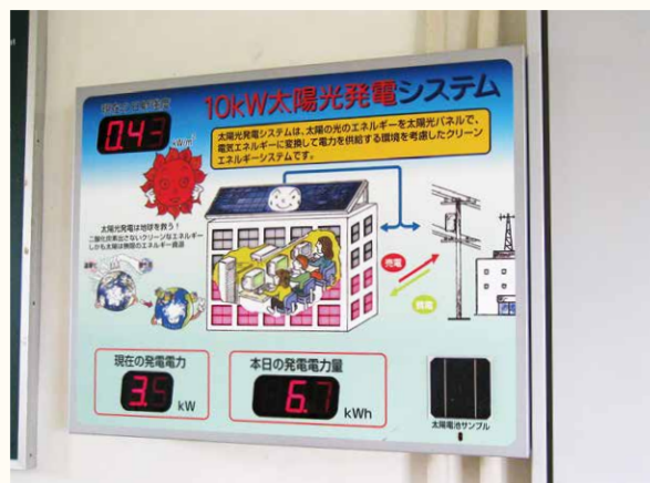
太陽光発電システムパネルの表示(附属坂出中学校)
