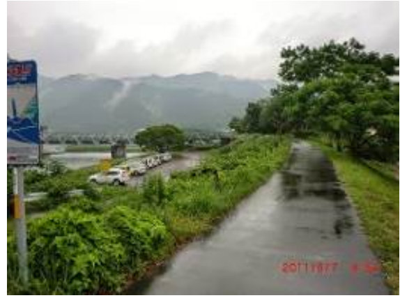
写真3 現在の松田川左岸の山付け堤防
