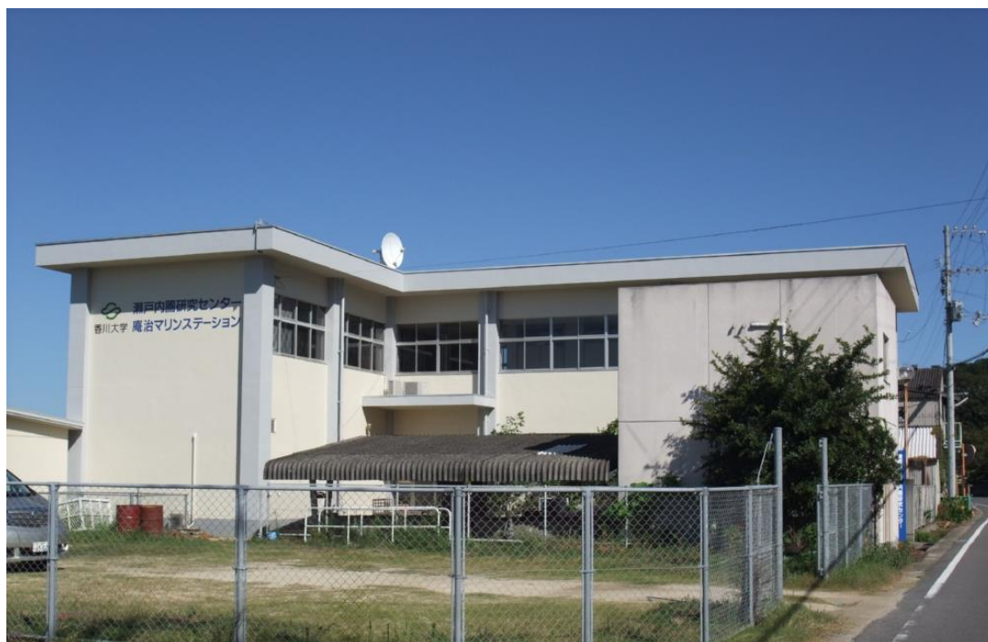
庵治マリンステーション全景
