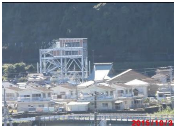
写真 20 横浜地区津波避難タワー
