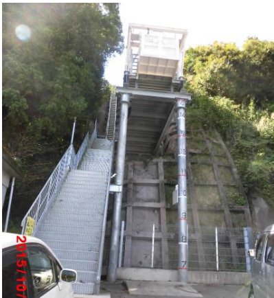
写真 14 山路地区津波避難タワー
