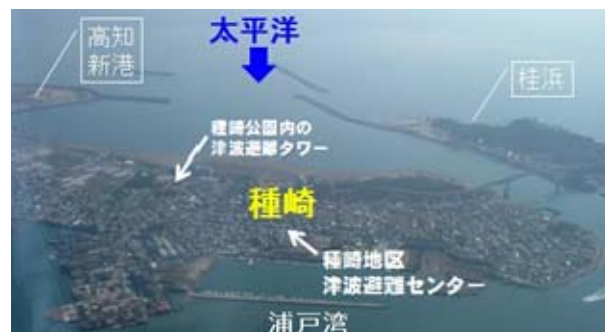
写真38 浦戸湾口部の現在の種崎集落と避難施設位置
