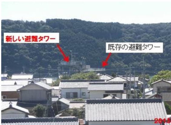
写真 18 既存タワーの横に嵩上げたタワー
