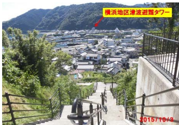
写真 21 海拔 30m の城山避難広場の避難階段
