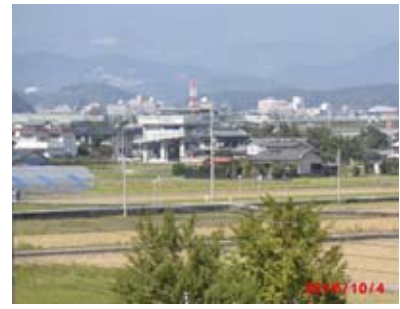
写真 43 下田村津波避難タワー
