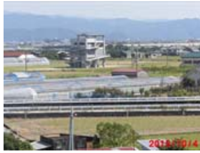
写真 42 久枝北津波避難タワー
