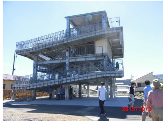
写真 17 水戸地区東津波避難タワー
