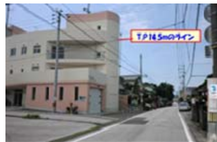
写真34 種崎地区津波避難センター
