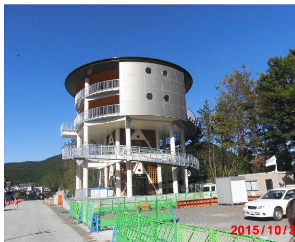
写真 25 屋上階 TP23.3mの純平津波避難タワー
