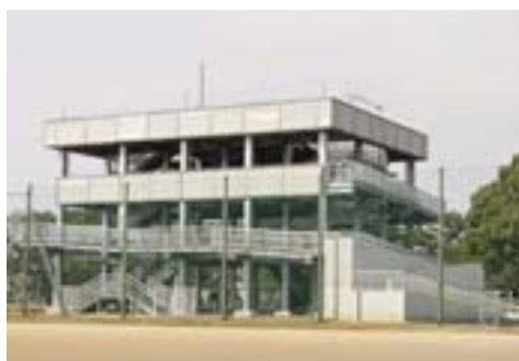
写真37 種崎公園内の津波避難タワー
