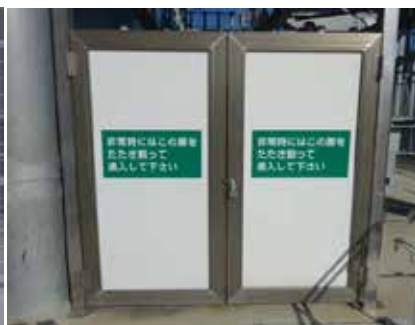
写真 2 普段上がることができない門扉施錠タイプ →緊急時は、階段登り口のボードを蹴破り通路を確保する。
