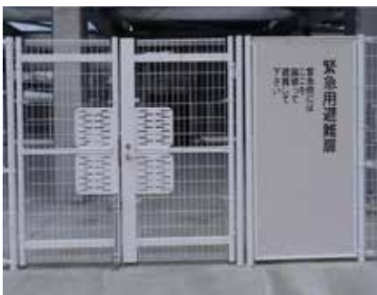
写真 2 普段上がることができない門扉施錠タイプ →緊急時は、階段登り口のボードを蹴破り通路を確保する。
