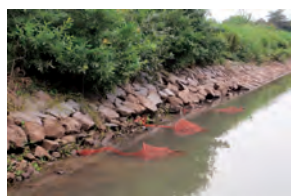
写真-2 堰堤沿い水際
