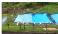
ブルーシートによる対策
