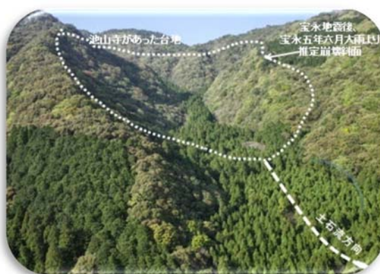
ドローンで撮影した崩壊地跡の写真
