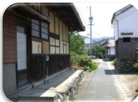
壁には腰板を張って保護した民家
