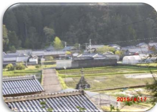
土石流の上に再興された現在の名留川集落
