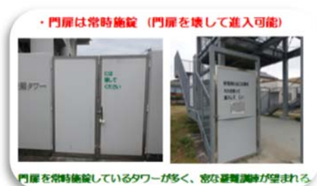
津波避難タワーの門扉写真
