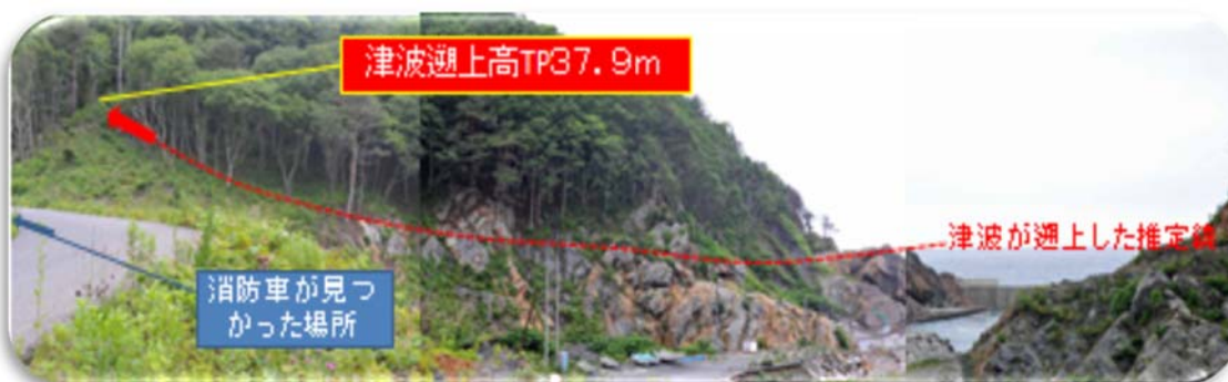
V 字型の陸地を遡上した津波痕跡が残る小堀内漁港（2013.6.28 撮影）
