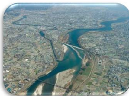
第十堰と吉野川堤防
