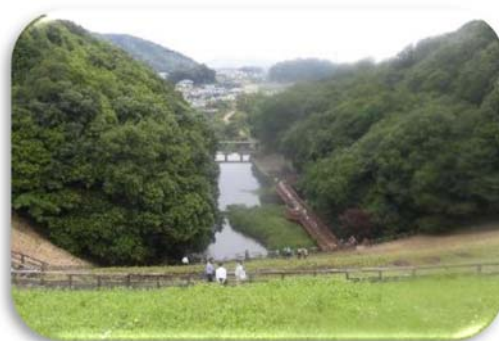
満濃池堰堤から金倉川を望む
