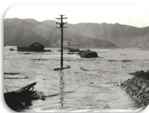
昭和 35. 5. 24 チリ津波 須崎市 (寸断された桐間堤防)
