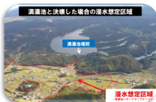
安政伊賀上野地震で決壊した満濃池
