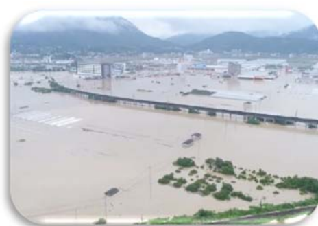
平成 30 年 7 月洪水で浸水した東大洲地区
