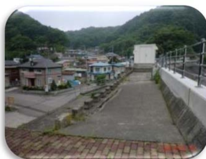
15.5m の普代防潮堤と守られた集落
