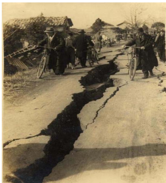
昭和南海地震の高知市鉄砲町（宝永町の西側現在の桜井町）の大亀裂(昭和21年12月21日撮影)
