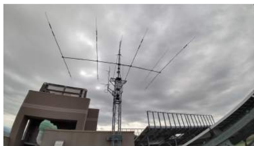
無線局アンテナ（創造工学部1号館屋上）
