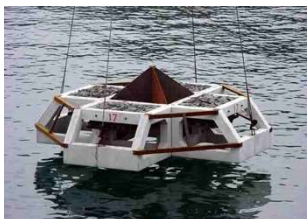
潮の流れをコントロールする 機能を持つ環境改善構造物
