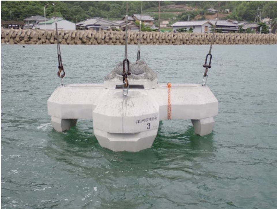
CO 2 吸収材を混入した藻場機能付き根固め被覆ブロック
