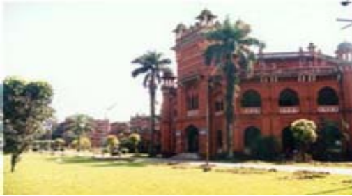
ダッカ大学の教育・研究棟の1棟
