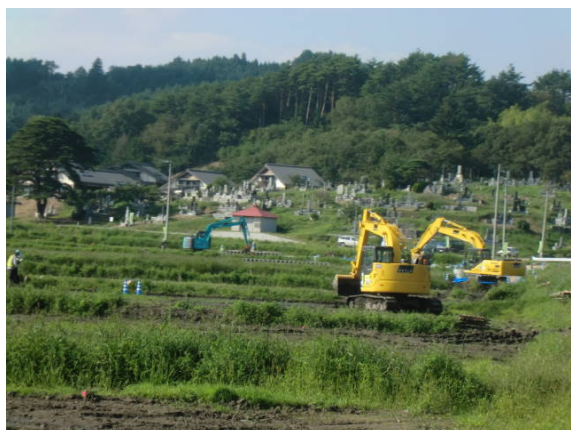
写真3 農地の重機による除染作業（飯館町）
