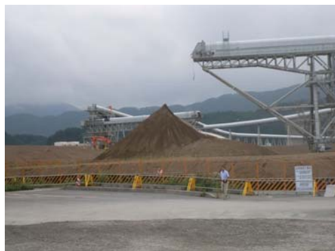
写真 106 道の駅「高田松原」周辺 (陸前高田市)
