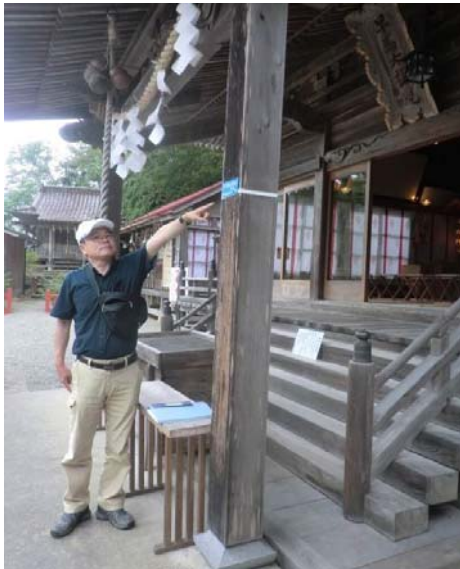
写真 20 拝殿の浸水位(青色の表示まで)
