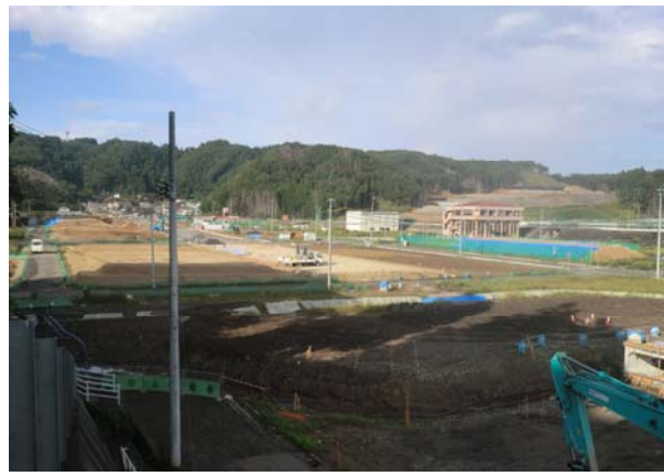
写真 98 土地かさ上げの土地区画整理工事
