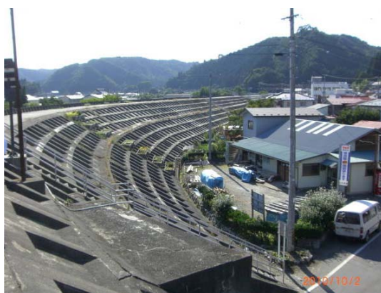
写真 96 田老の防浪堤 (2010. 10. 2 撮影)
