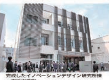
完成したイノベーションデザイン研究所棟
