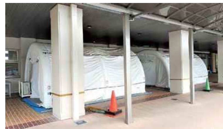
陰圧テントを2基設置
