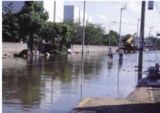
◎高松市内道路の浸水被害の状況
