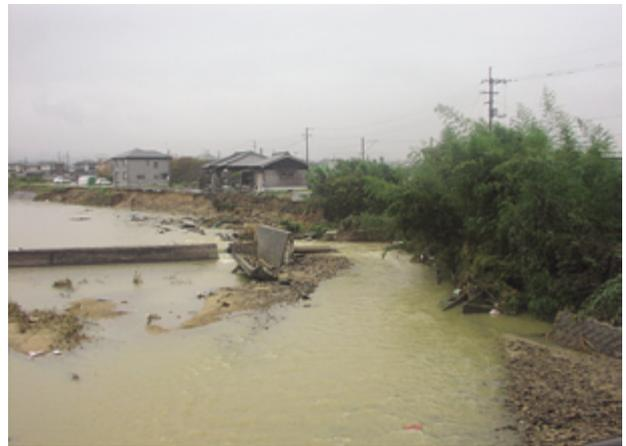
図22 新川福万大橋の護岸の被災
