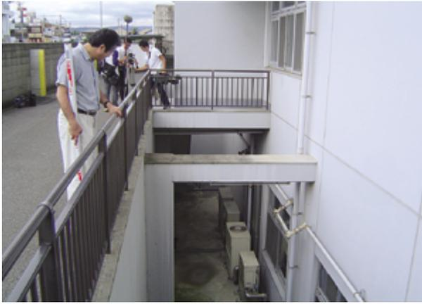
図2(a) ドライエリア（蹴上げ高さ20cm）
