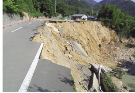
図16 盛土の崩壊によって平成17年3月現在通も行止めが続く国道377号線（東かがわ市入野山）
