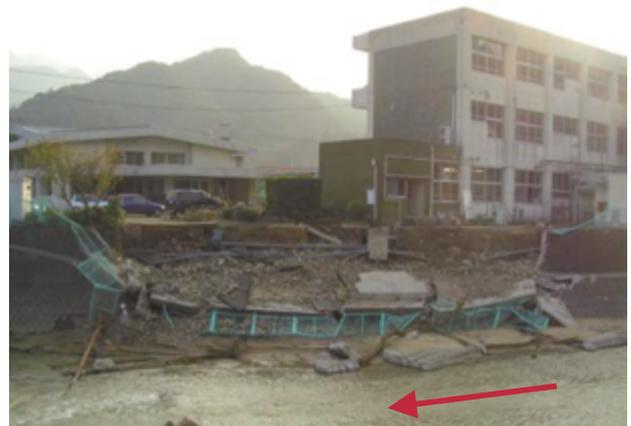
図18 湊川沿いの福栄小学校の被災（護岸と構造物の転倒と流失）
