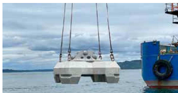
藻場造成構造物を沈設する様子
