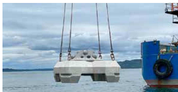
藻場造成構造物を沈設する様子
