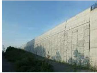
土でつくられた社会基盤構造物の例（補強土壁）
