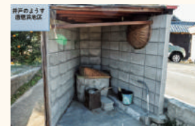
(写真1)水位変動を継続的に計測した豊島唐櫃浜地区の井戸
