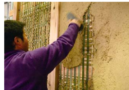
土塗壁の施工風景
