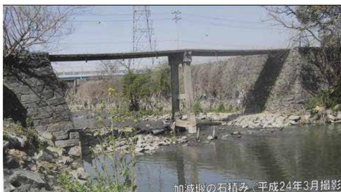
写真1 下流への洪水を加減する「加減閘(堰)」
