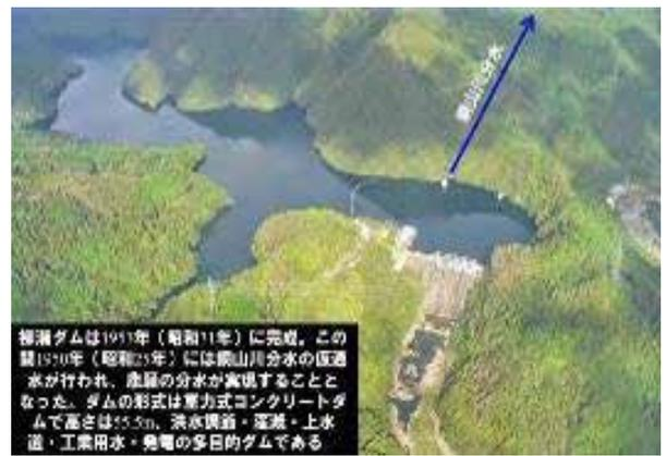
柳瀬ダムは1955年(昭和30年)に完成。この翌1956年(昭和31年)には銅山川分水の区画水が行われ、産屋の分水が実現することになった。ダムの形式は重力式コンクリートダムで高さは55.5m。洪水調節・灌漑・上水道・工業用水・発電の多目的ダムである
