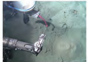
砂で埋設孔と筐体の隙間を後埋設
