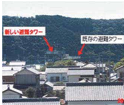
写真5 嵩上げタワーと集落
