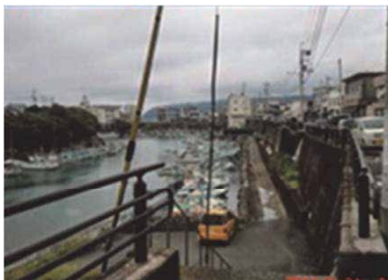
写真3 掘り込み港の室津港
