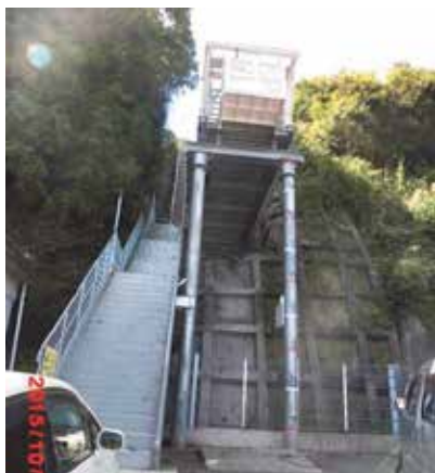
写真 1 山路地区津波避難タワー
