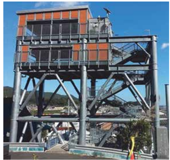
写真2 横浜地区津波避難タワー
