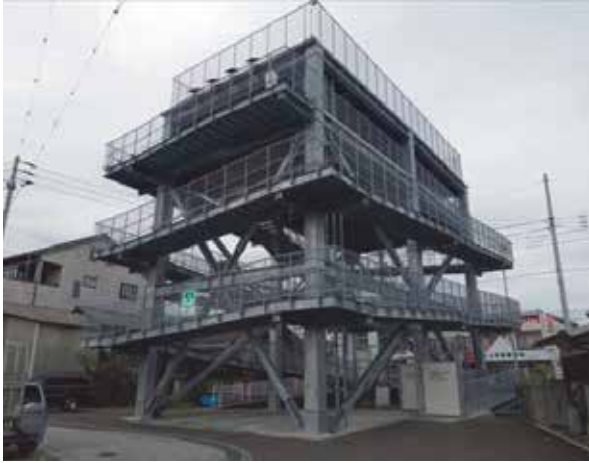
写真1 安芸市津波避難タワー1号
