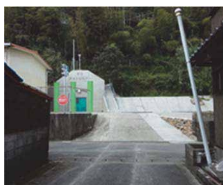
写真 5 都呂避難シェルター進入路
