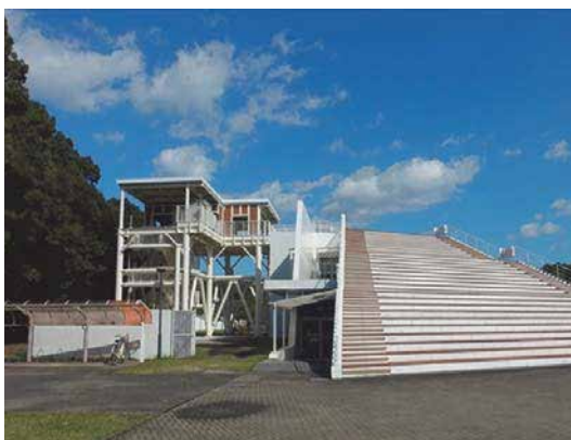
写真1 浜の宮津波避難タワー
