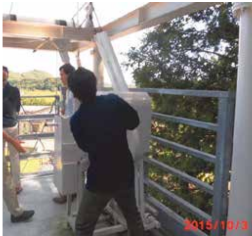
写真 4 手動で吊り上げている様子
