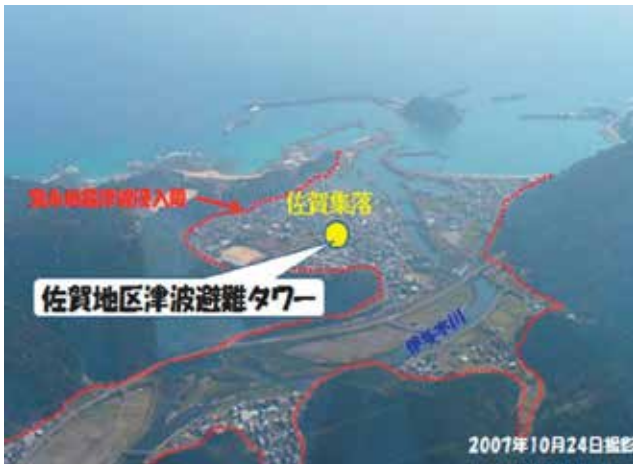
写真4 宝永津波浸水限と佐賀地区津波避難タワー
