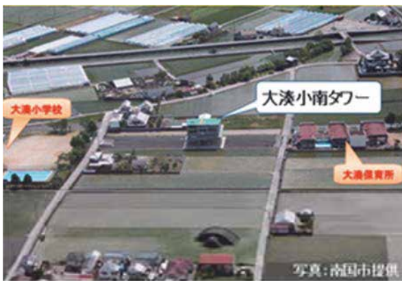
写真 1 小学校と保育所の中間にあるタワー
