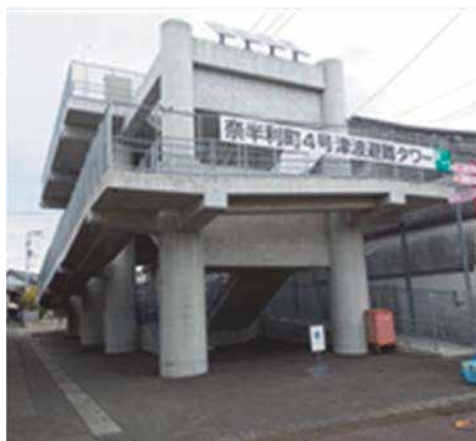
写真1 奈半利町4号津波避難タワー
