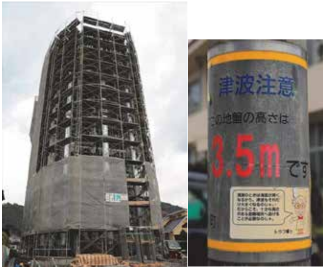
写真1 佐賀地区津波避難タワーと地盤高
