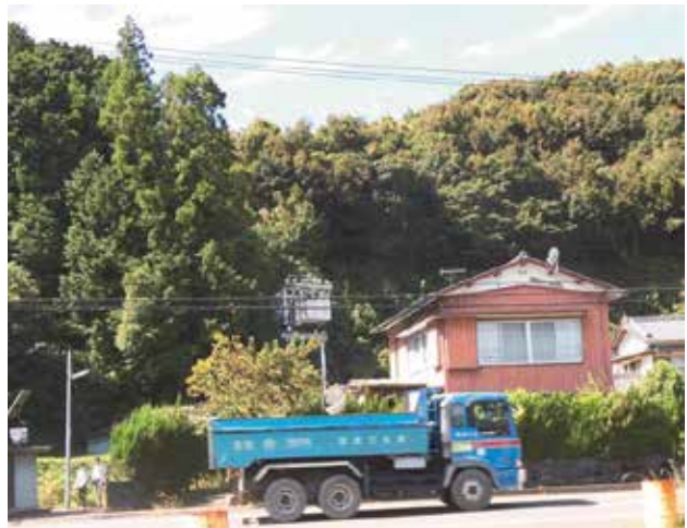
写真 5 急斜面に建設された避難タワー
