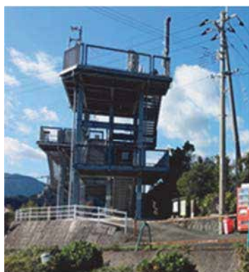
写真 1 下田水戸地区津波避難タワー
