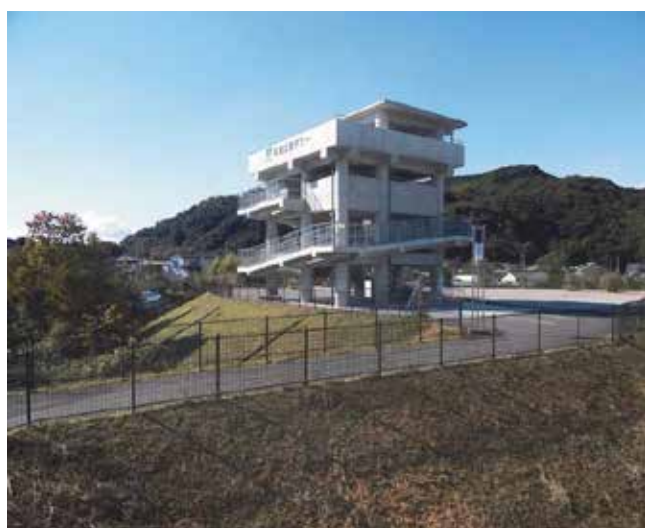
写真1 甫湊公園津波避難タワー
