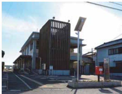
写真1 岸本防災コミュニティセンター
