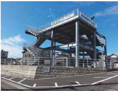
写真1 室津東町津波避難タワー
