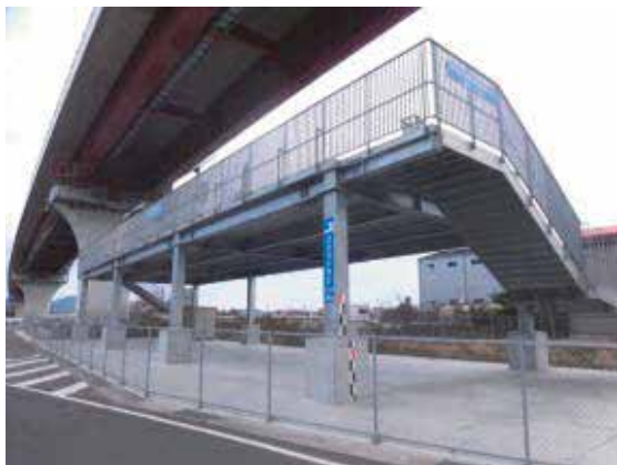
写真 1 中村老門地区津波避難タワー
