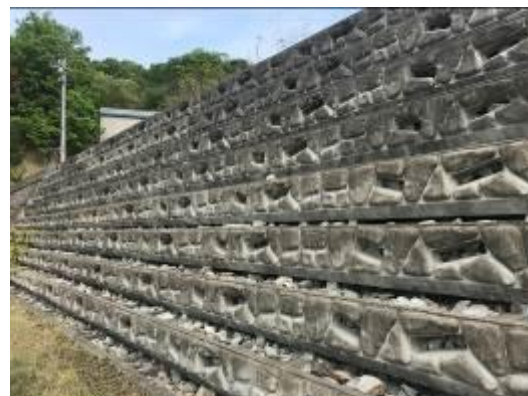
石詰め構造物
