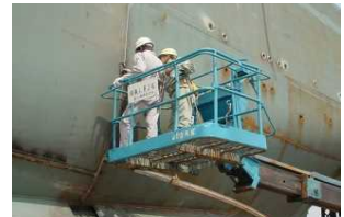
船体外板の検査をする船舶検査官
