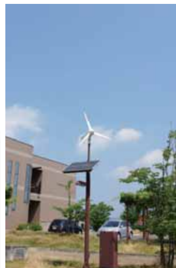
林町キャンパスに設置された 風力発電システム
