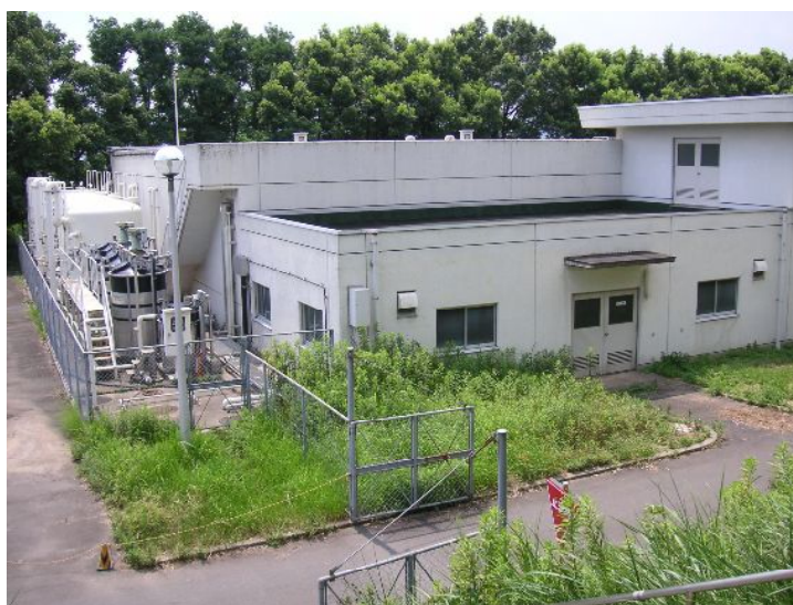
適正に処理して排水（排水処理施設（三木町医学部キャンパス））
