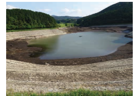
緊急放水により低下した水位
