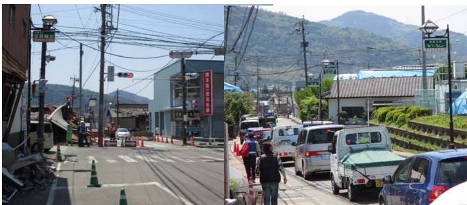
益城町役場付近では県道28号より南側の建物被害が甚大
