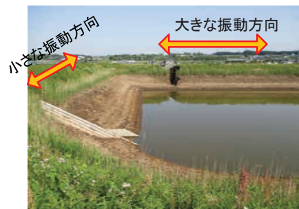
断面方向にクラックの発生 → 引張破壊
