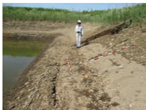
断面方向にクラックの発生 → 引張破壊
