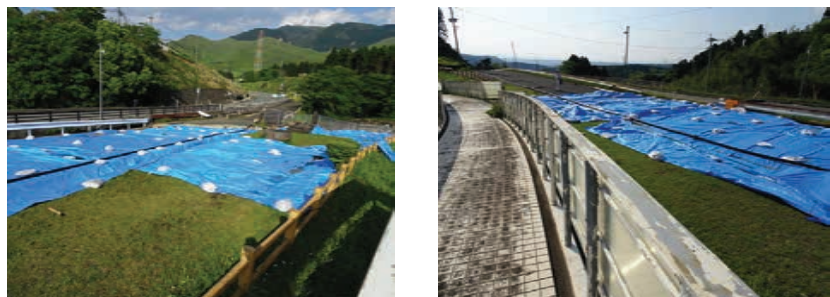
堤体天端を覆うブルーシート
