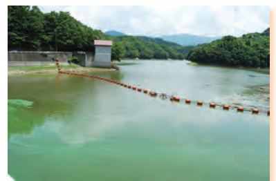
植物プランクトン（ラン藻）が大量に発生し、湖面上に集まっています。水質汚濁の原因になり、水利用が制限されます。
