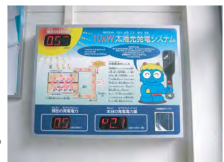
太陽光パネルでの発電状況を表示
