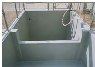
防水加工を行った浄化施設の貯留槽
