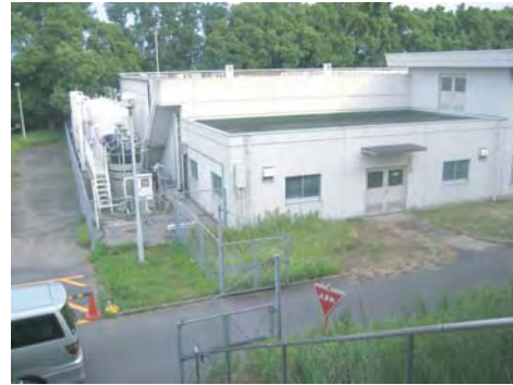
三木町医学部キャンパス内にある排水処理施設
