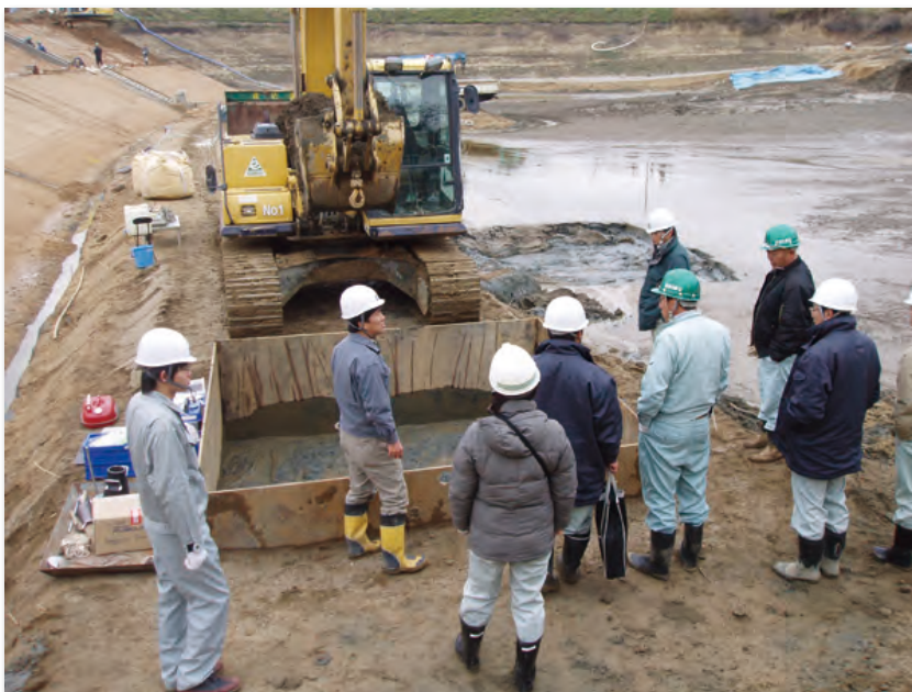
現場でのため池底泥の堤体への活用の研究
