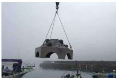
人工魚礁の沈設の様子
