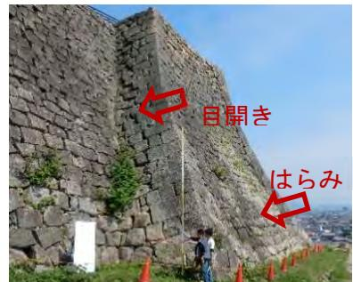
図-1 変状の進む丸亀城石垣
