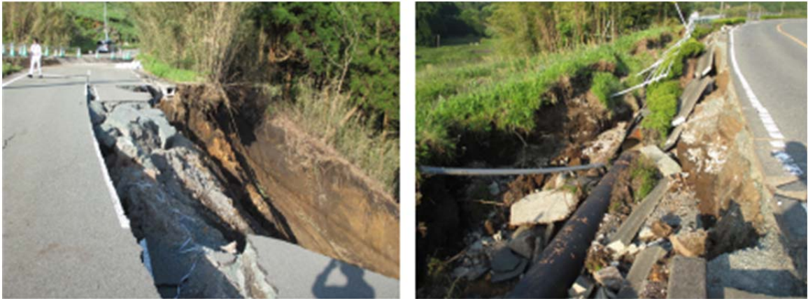
図 4.7 路肩盛土の崩壊（左：国道 298 号南阿蘇村沢津野，右：県道 28 号西原村風当）。
