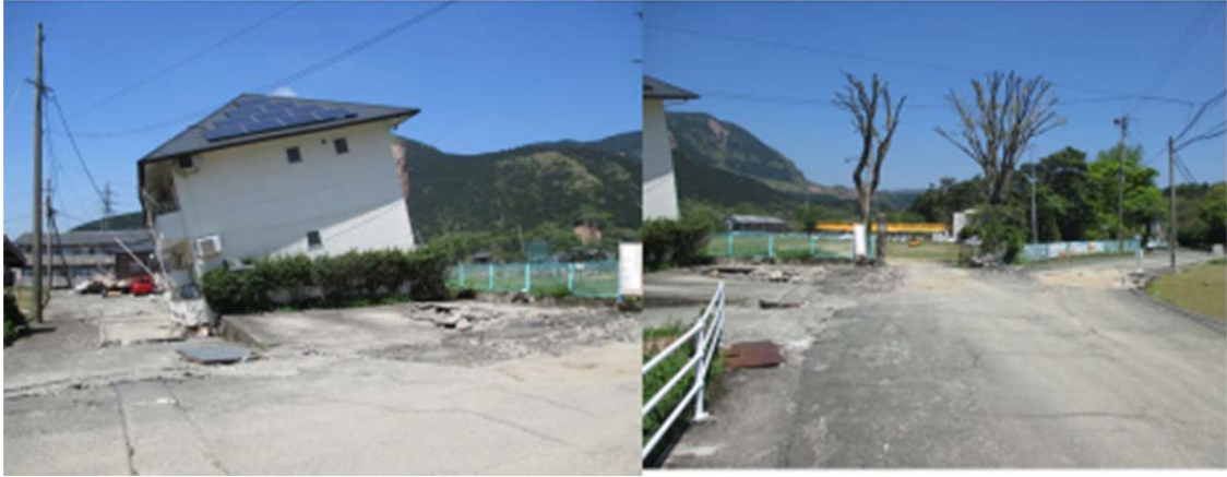
図 3.16 右横ずれを示す地表地震断層による道路の変位（右）とその延長にぶにあるアパートの倒壊（南阿蘇村黒川付近：㊸地点）
