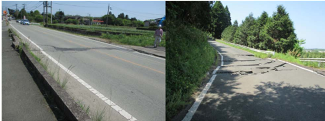
図 3.10 西原村布田地区におかる道路の亀裂 (左：⑥地点，右：⑦地点)
