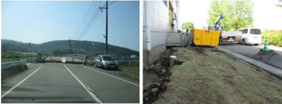
図 4.9 橋梁構造物と盛土との段差（左）とマンホールの浮き上がり（右：益城町総合体育館）。
