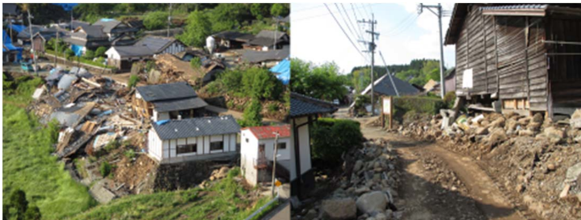
図 3.13 西原村大切畑地区における盛土の崩壊による家屋の倒 (㊠地点)
