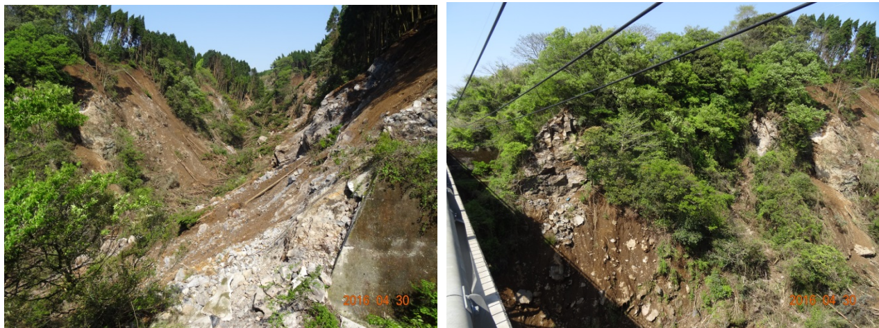
図 5-10 支流の両岸斜面が崩壊（左）緩んだ岩盤と崖錐（右）（地点⑤）
