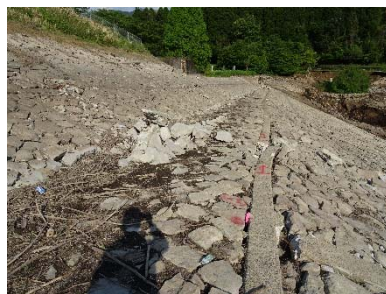
(b) コンクリート枠の圧縮破壊
