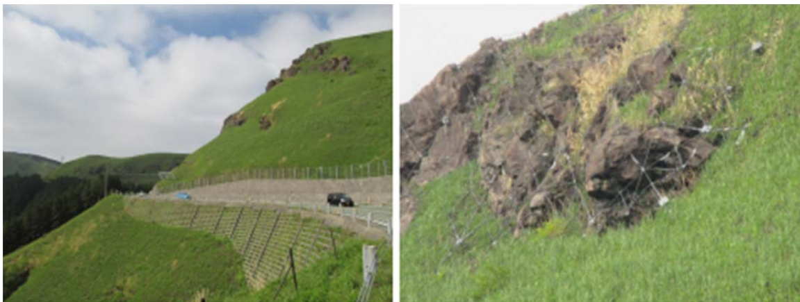
図 4.12 道路上方斜面の落石対策（県道 23 号阿蘇村市二重峠）。
