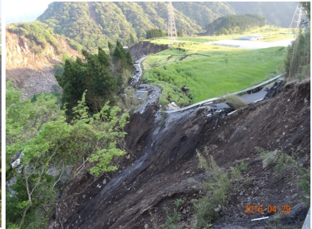
図 5-7 地点②の段丘崖の崩壊（左）と段丘面の変状と水田に出来たクラック（右）
