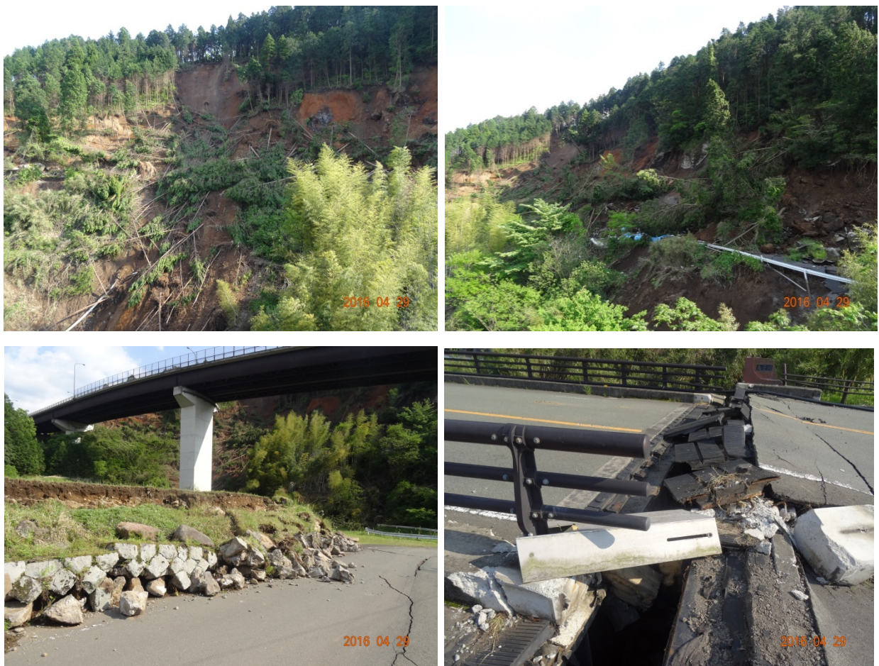
図 5-13 地点⑦の大峯山北斜面の大規模崩壊。崩壊斜面 (左上), 崩壊土砂によって寸断した旧道 (右上), 崩壊土砂が直撃せず落橋を免れた大切畑大橋 (左下と右下)
