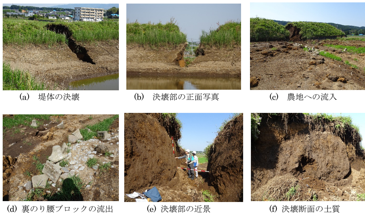
図 6.4 下小森ため池の被災状況
