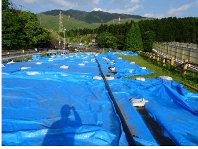
(e) 堤体クラックを覆うシート
