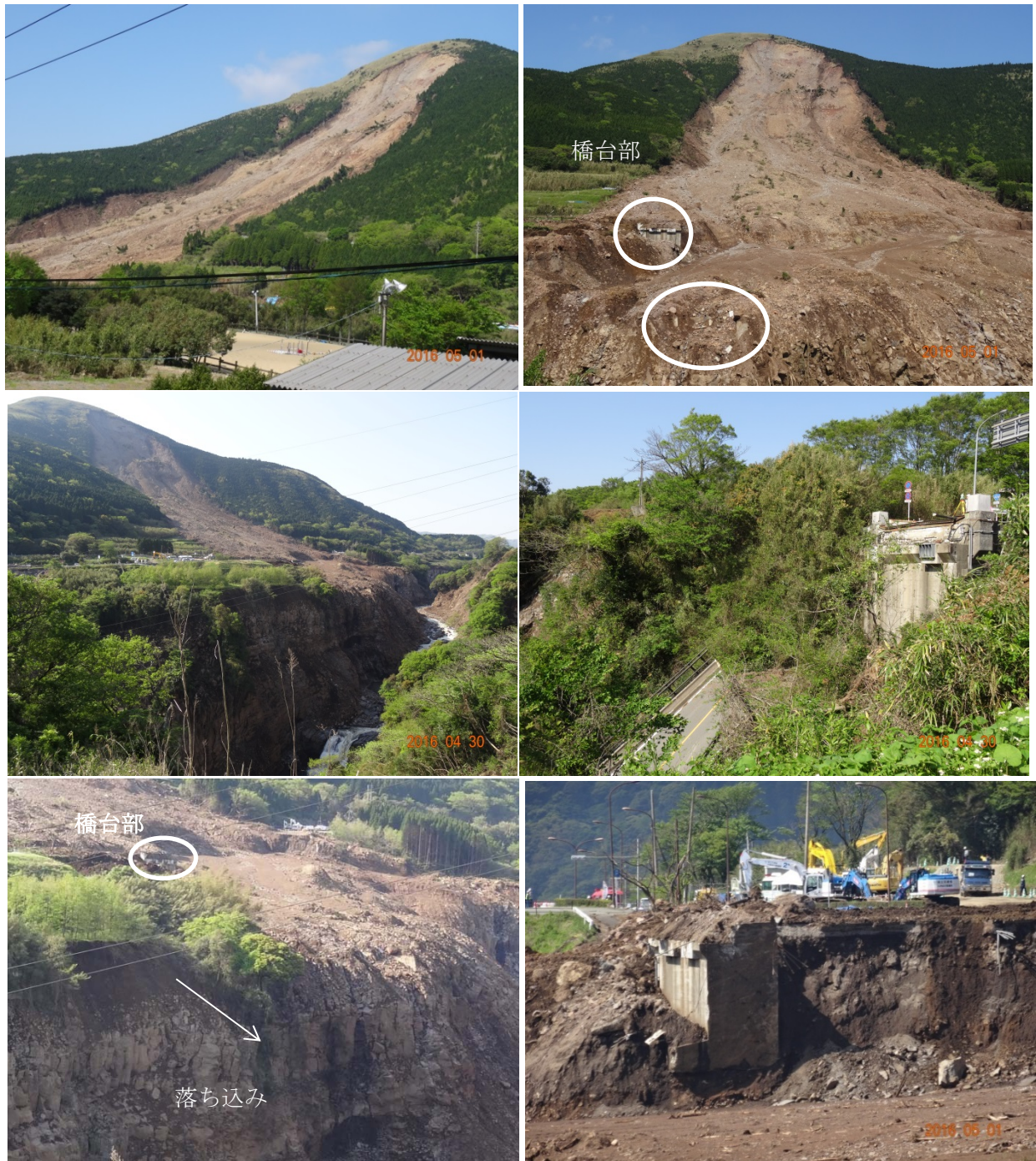
図 5-4 阿蘇大橋付近の大規模崩壊（地点①）。左岸上流側から（左上）、左岸正面から（右上）、左岸下流側（左中）から撮影した崩壊斜面と左岸側橋台と崩落した道路（右中）。河岸段丘上での崩壊斜面側への落ち込み（左下）と道路と接合していない橋台（右下）
