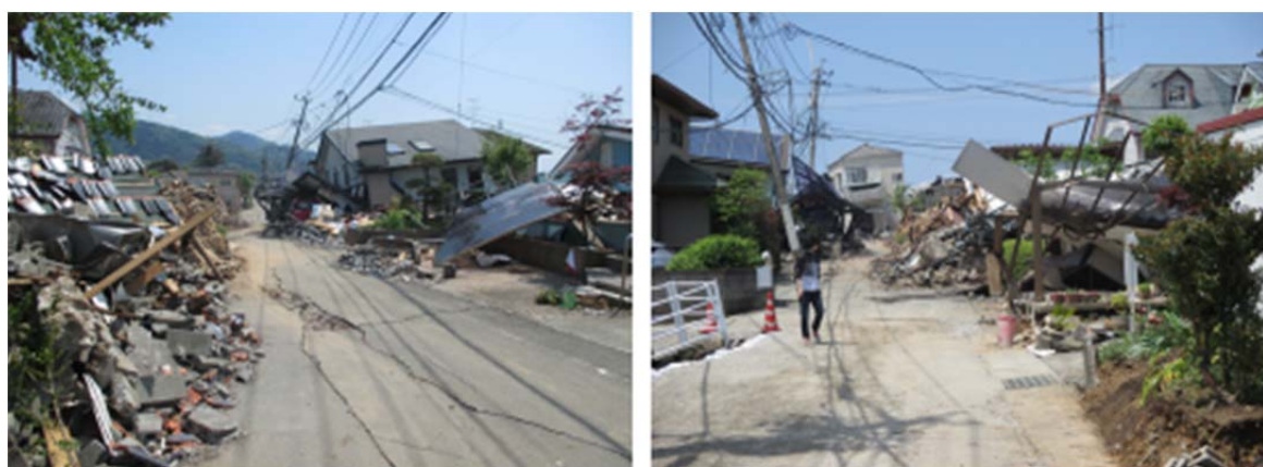
図 3.7 益城町木山地区南部の道路の地割れ（④地点），右横ずれ 0.5m
