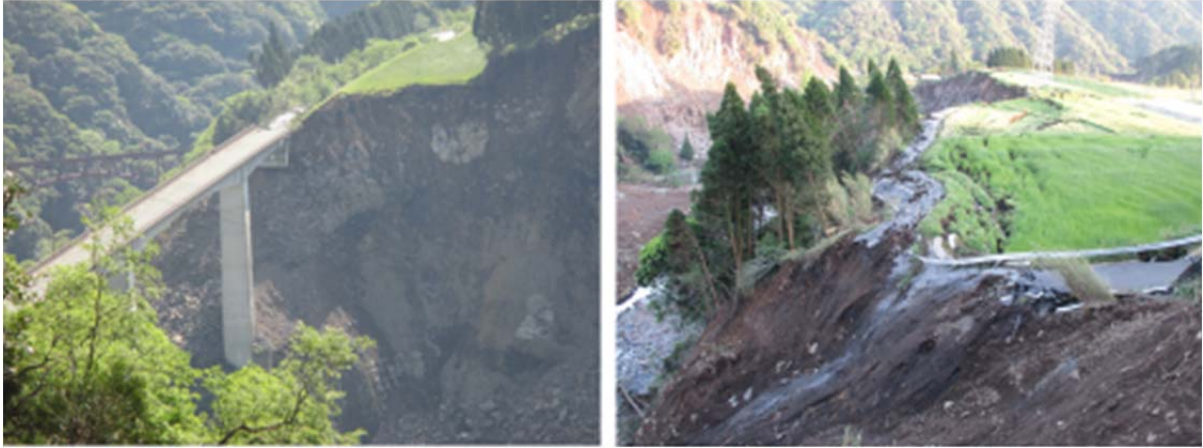
図 4.3 白川を横断する阿蘇長陽大橋はアバット斜面が崩壊している（左）。 旧道も斜面崩壊によって寸断されている（右）。
