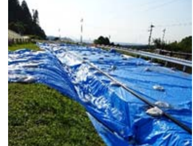
(f) 道路との境に生じたクラック
