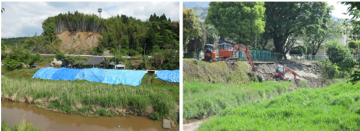
図 4.10 木山川左岸堤防のクラックを覆うブルーシートと復旧工事（益城町上陳）
