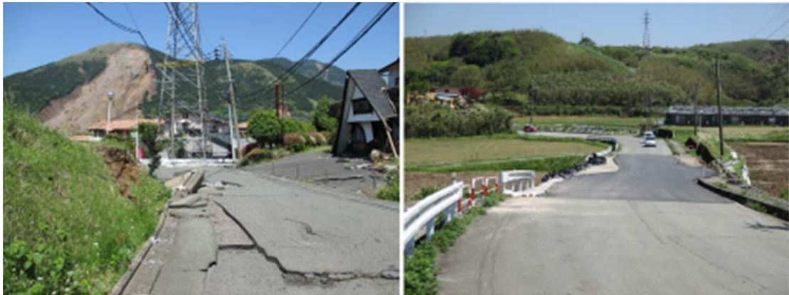
図 4.8 地表地震断層による道路の被害（南阿蘇阿蘇村）。
