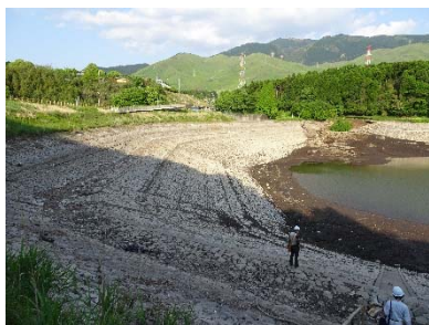
(a) 堤体（表のり面）の状況
