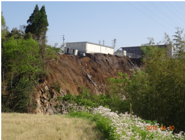
図 5-9 地点④のコンビニエンスストア背後の段丘崖の崩壊（左）と駐車場のクラック（右）
