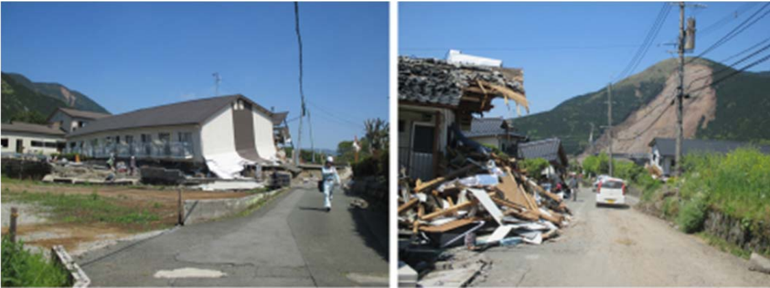
図 3.17 盛土地盤に建てられたアパートの倒壊（左：㊹地点）と古い民家の倒壊（右：㊻地点）
