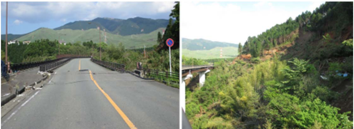
図 4.4 県道 28 号の西原村の大切畑大橋（平成 13 年 3 月竣工）が大規模地すべりにって沈下，移動しているが，落橋は免れていた。
