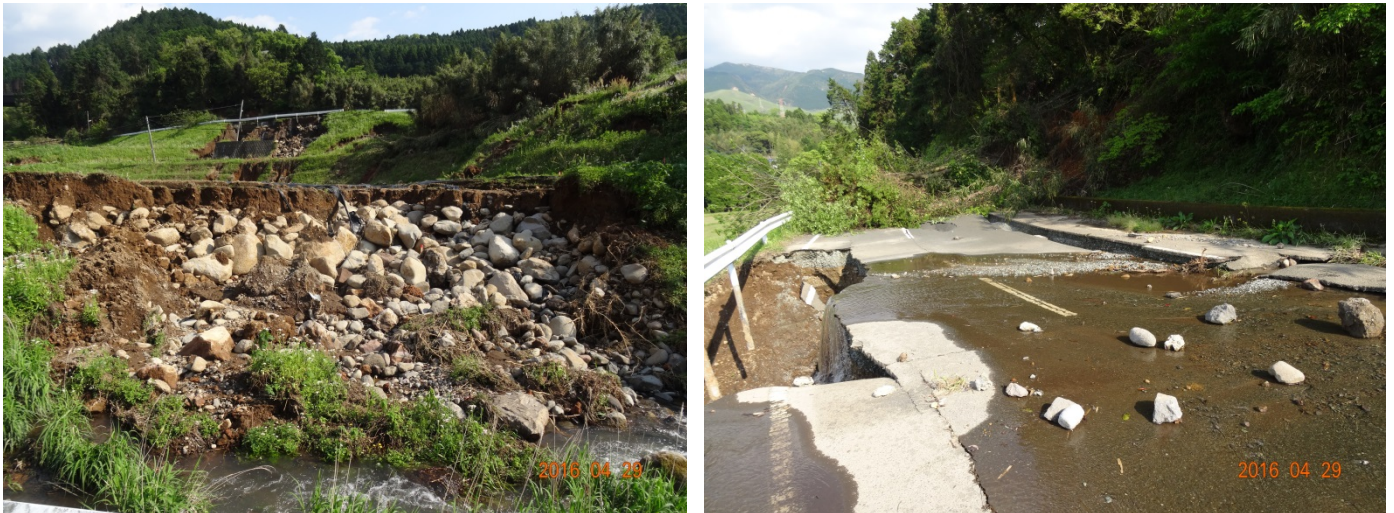
図 5-14 地点⑧の棚田堤体の変状（左）と水の流出（右）
