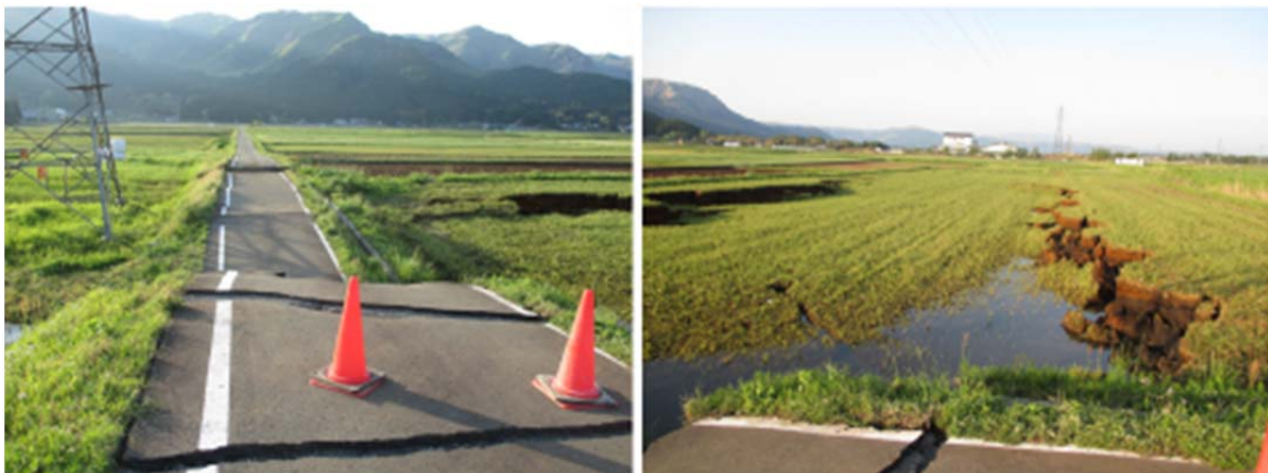
図 3.19 阿蘇カルデラ内の沖積平野に形成された陥没帯（阿蘇市市ノ川駅西方：⑬地点）
