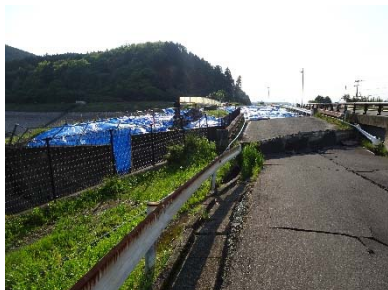
(d) 堤体天端に生じた段差
