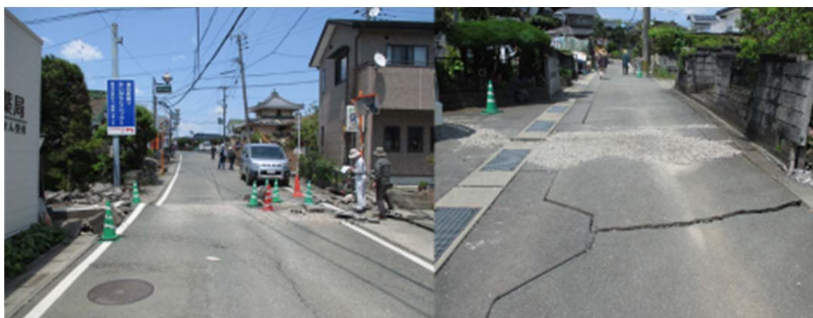
図 3.6 益城町木山地区南部の道路の地割れ（④地点），右横ずれ 0.5m
