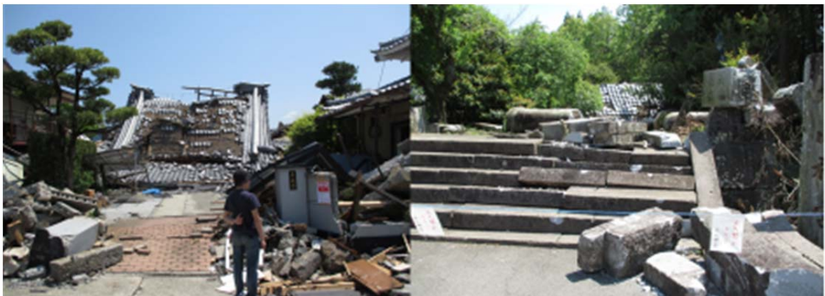
図 3.8 益城町木山地区南部におけるの寺院と木山神社の被害状況
