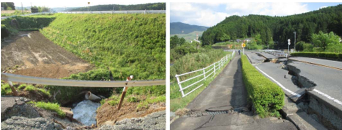
図 4.5 県道 28 号の風当では谷埋め盛土が沈下していた。
