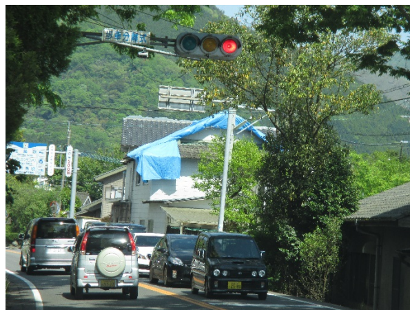
図 3.21 屋根を覆うブルーシート（由布市）
