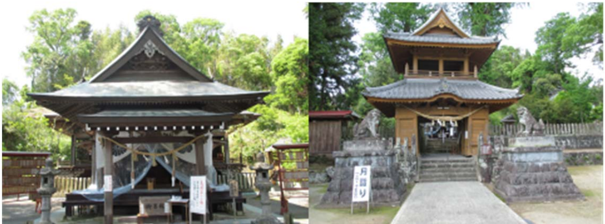
図 3.7 益城町寺中地区津森神社の被害状況。 拝殿等の建物だけでなく、狛犬や石灯籠は倒壊していない。
