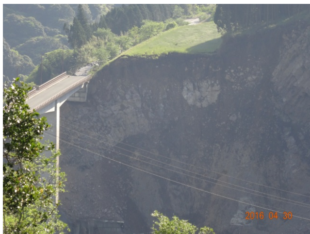
図 5-11 阿蘇長陽大橋橋台付近の崩壊（図 5-3 地点⑥）
