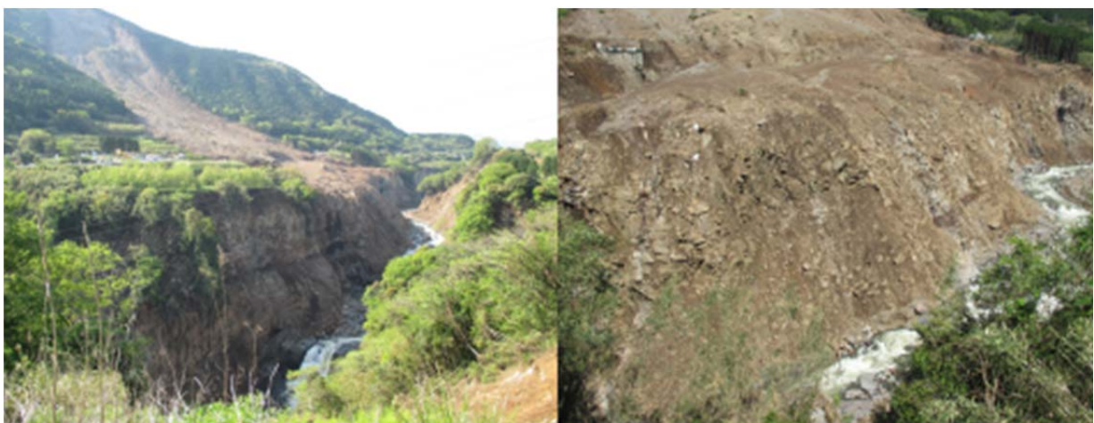
図 4.2 国道 57 号阿蘇大橋は、地震による斜面崩壊によって崩落している。
