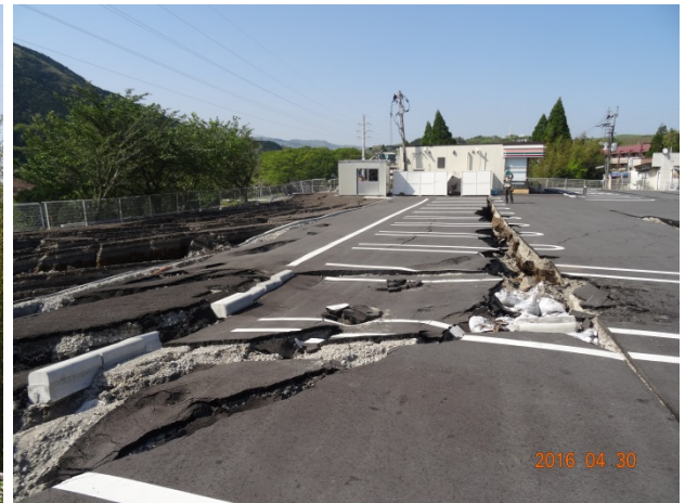
図 5-9 地点④のコンビニエンスストア背後の段丘崖の崩壊（左）と駐車場のクラック（右）
