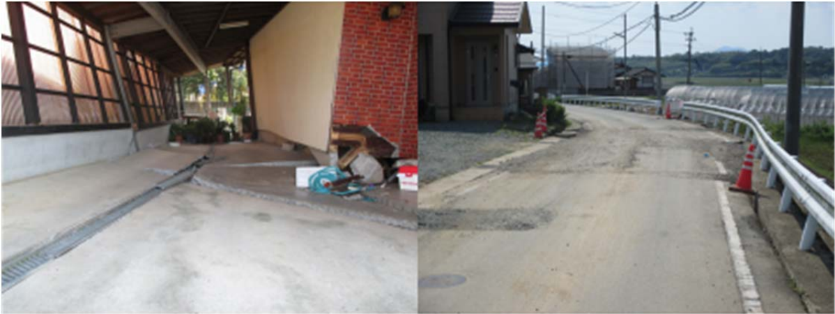
図 3.3 地表地震断層による道路と民家の右横ずれ変位（益城町下陳①地点）
