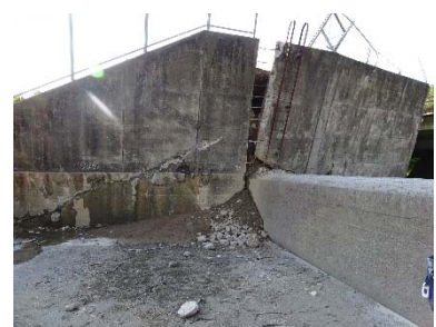
(c) 洪水吐の被害
