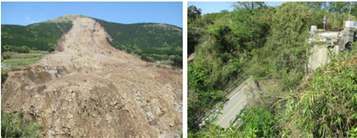
図 4.1 国道 57 号阿蘇大橋は、地震による斜面崩壊によって崩落している。
