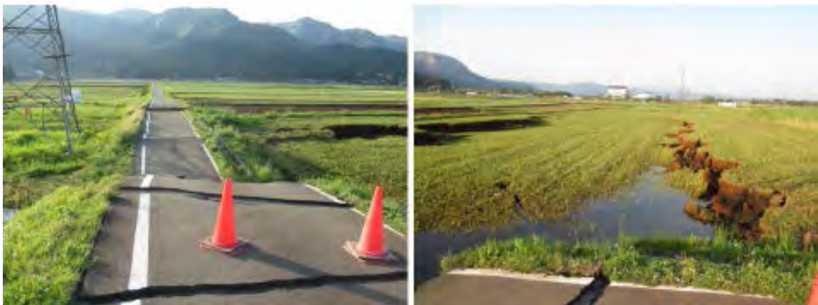
図 3.19 阿蘇カルデラ内の沖積平野に形成された陥没帯（阿蘇市市ノ川駅西方：⑮地点）
