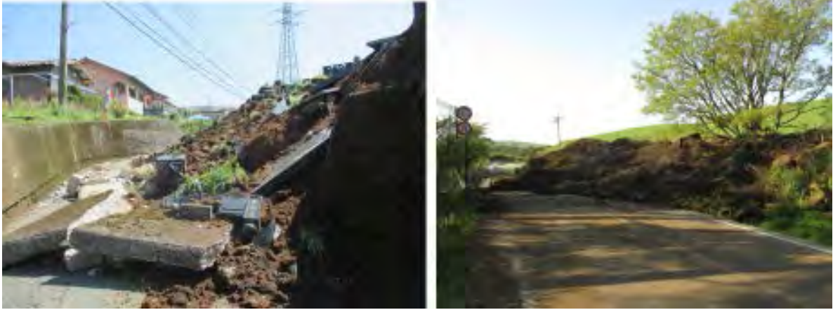
図 4.6 道路擁壁の崩壊（左：南阿蘇村黒川，右：阿蘇パノラマライン南阿蘇村）。
