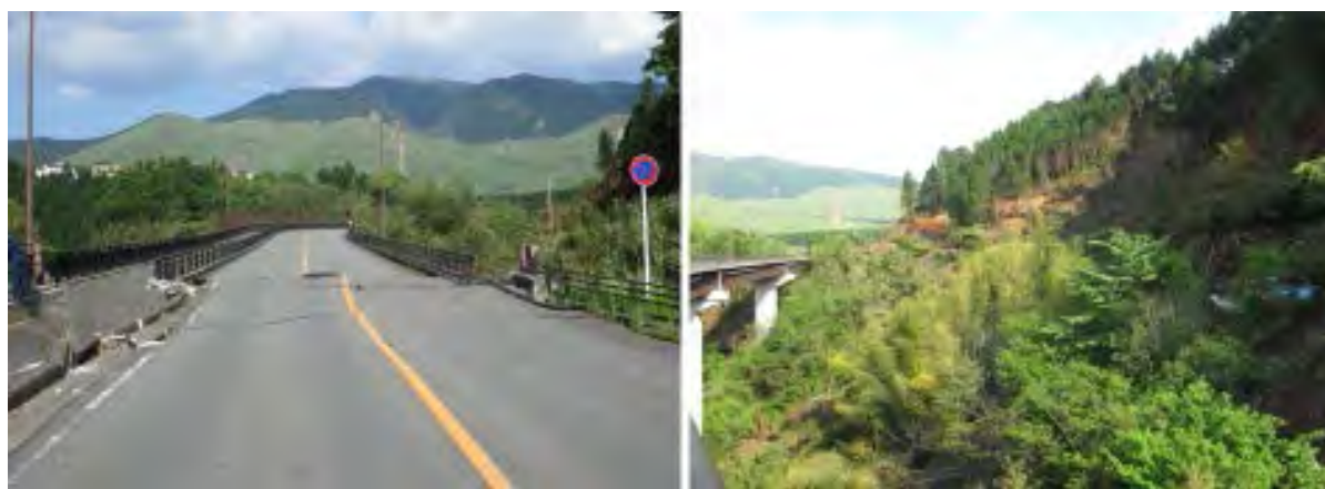
図 4.4 県道 28 号の西原村の大切畑大橋（平成 13 年 3 月竣工）が大規模地すべりによって沈下，移動しているが，落橋は免れていた。
