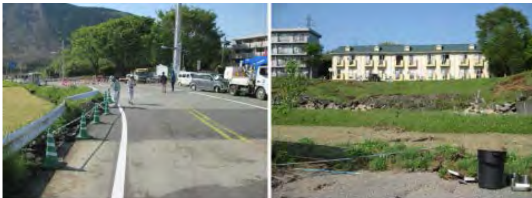
図 3.15 右横ずれを示す地表地震断層による国道 325 号の路面の変位（左）とその延長にぶにあるアパートの損傷（南阿蘇村黒川付近：⑪地点）
