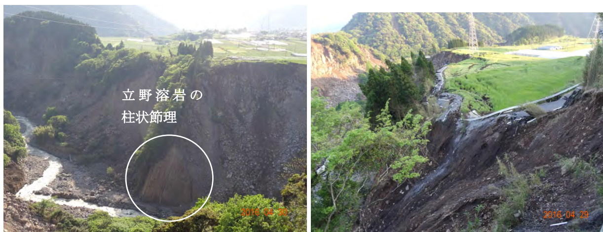
図 5-7 地点②の段丘崖の崩壊（左）と段丘面の変状と水田に出来たクラック（右）
