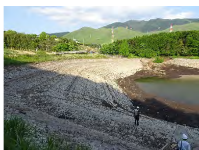
(a) 堤体（表のり面）の状況
