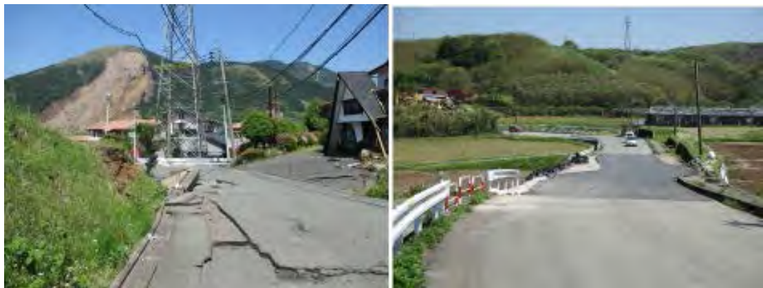
図 4.8 地表地震断層による道路の被害（南阿蘇阿蘇村）。
