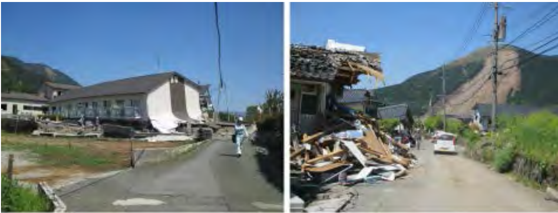
図 3.17 盛土地盤に建てられたアパートの倒壊（左：⑭地点）と古い民家の倒壊（右：⑬地点）
