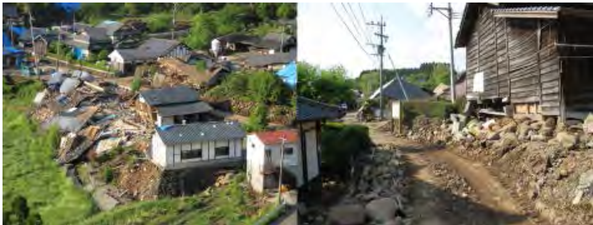
図 3.13 西原村大切畑地区における盛土の崩壊による家屋の倒（⑩地点）
