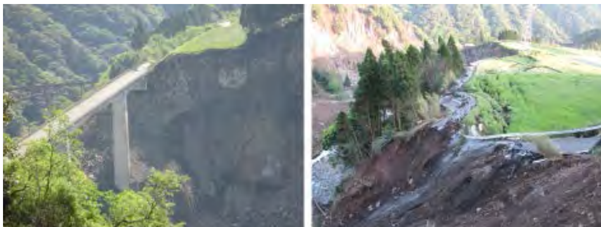
図 4.3 白川を横断する阿蘇長陽大橋はアバット斜面が崩壊している（左）。 旧道も斜面崩壊によって寸断されている（右）。
