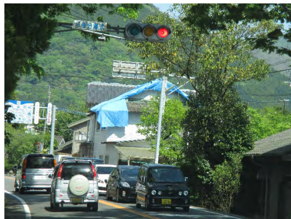
図 3.21 屋根を覆うブルーシート（由布市）
