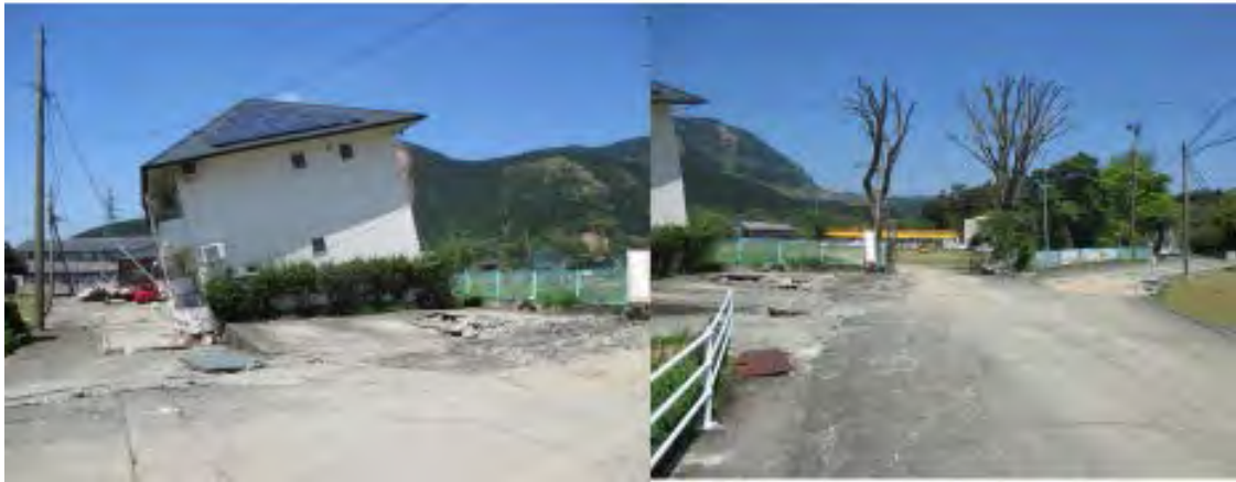
図 3.16 右横ずれを示す地表地震断層による道路の変位（右）とその延長にぶにあるアパートの倒壊（南阿蘇村黒川付近：⑫地点）
