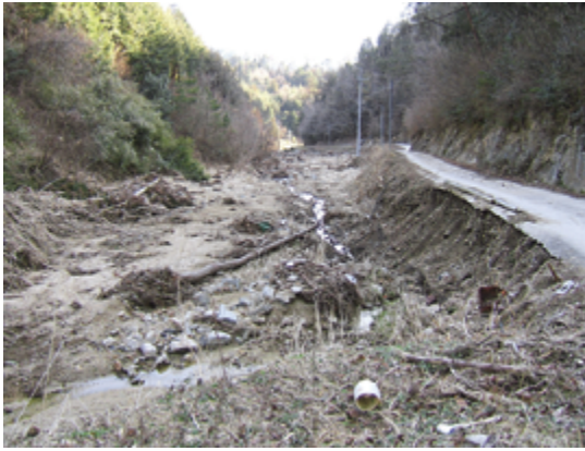
写真11 土砂により埋没した水田
