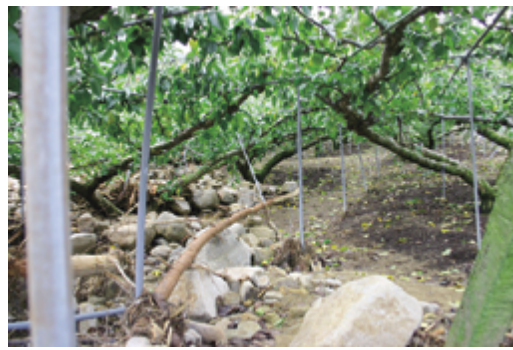
写真8 土石流によるナシ栽培棚の損壊(豊浜町)
