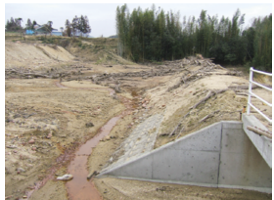
写真7 砂防堰堤の役割をした馬河池
