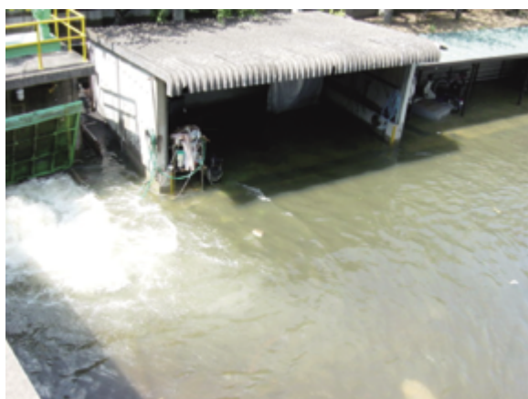
写真5 福岡ポンプ場の流入ゲート付近
