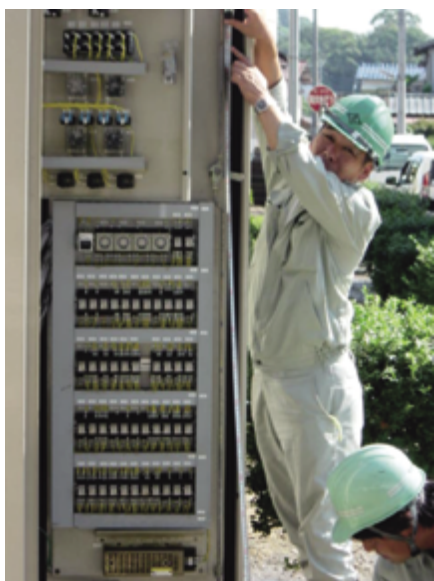
写真3 香西ポンプ場の浸水深
