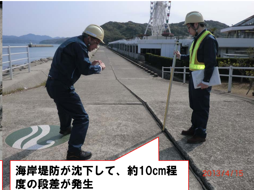
歩道の舗装割に段差が ついた砂噴出跡
