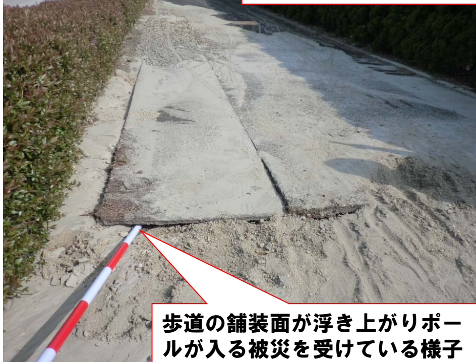
歩道の舗装割に段差が ついた砂噴出跡
