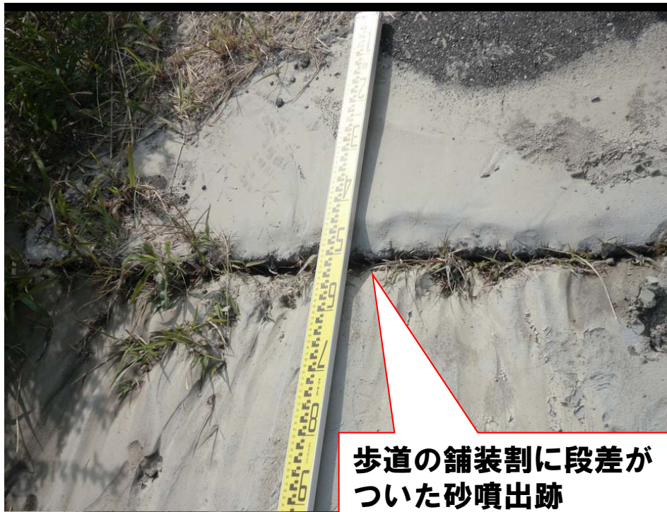
海岸堤防が沈下して、約10cm程 度の段差が発生
