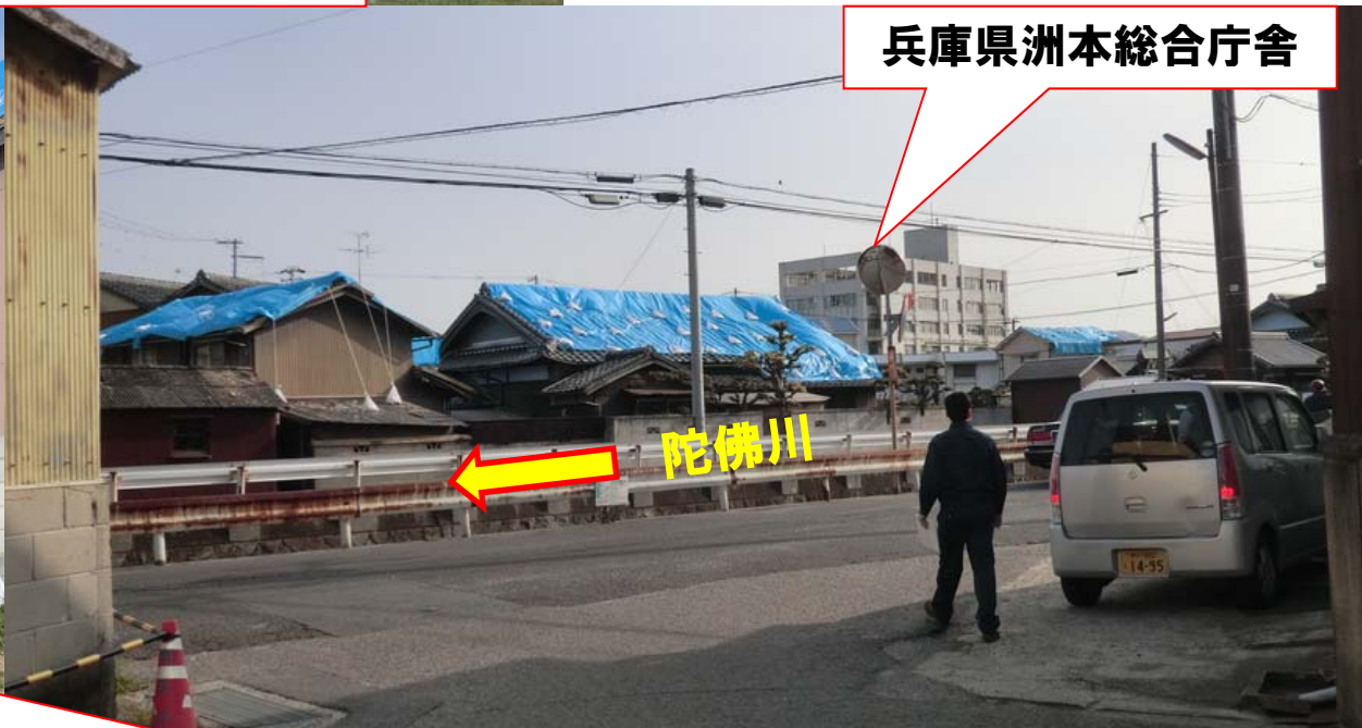
壊れた瓦や壊れたブロック塀などのガレキが集められている屋根はシートで応急処置が施されている様子
