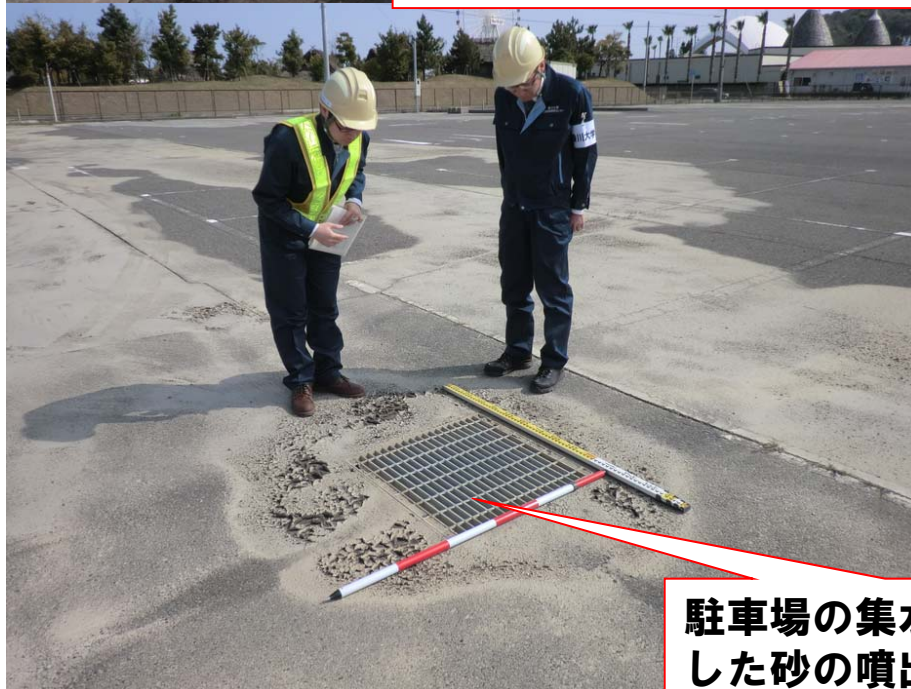
歩道に舗装面に液状化現象跡
