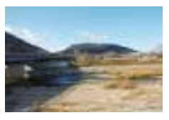
金山遠景 綾川から見る。
