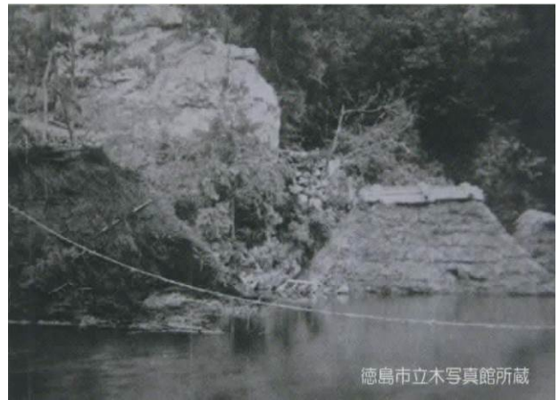
写真3 高磯山の崩壊上流の被害状況
