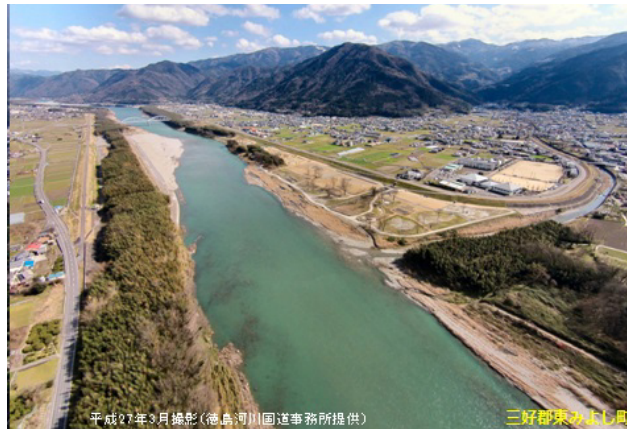
写真 3 平成 27 年 3 月時点の吉野川上流の水防林の様子 (2015 年 3 月撮影写真徳島河川国道事務所提供)
