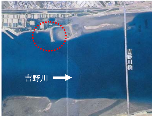
写真1 平成11年5月17日大潮干潮時写真
