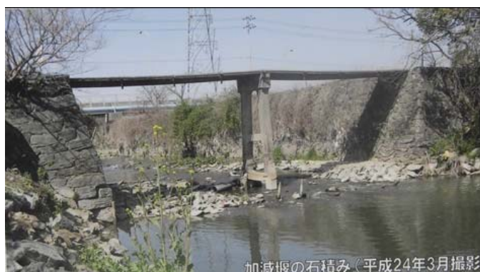
写真1 下流への洪水を加減する「加減閘(堰)」
