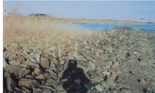
水制頭部(縦工)の状況 (H8. 2. 22 撮影)
