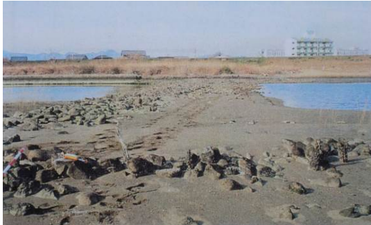
写真2 水制幹部(横工)の状況 (H8. 2. 22 撮影)
