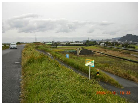
写真2 ガマン堰があった付近的那賀川堤防
