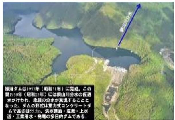
柳瀬ダムは1957年(昭和32年)に完成。この翌1958年(昭和33年)には銅山川分水の区画水が行われ、産屋の分水が実現することになった。ダムの形式は重力式コンクリートダムで高さは55.5m。洪水調節・灌漑・上水道・工業用水・発電の多目的ダムである
