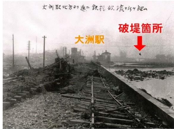
写真2 大洲駅上流の肱川堤防の破堤箇所
